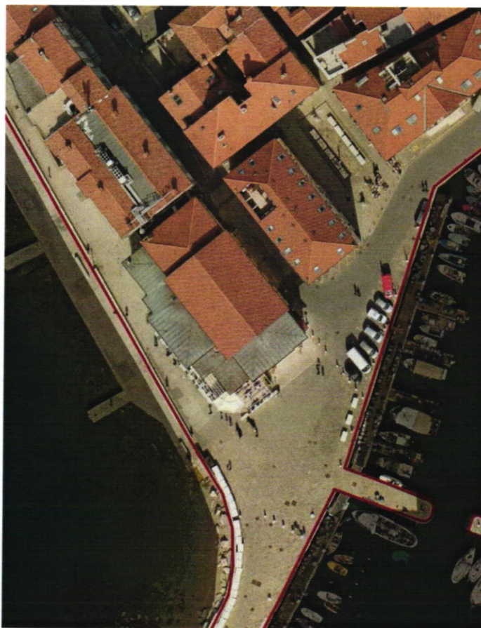
Stavba gledališča Piran s tendami nad terasami-spodnja stavba na fotografiji
